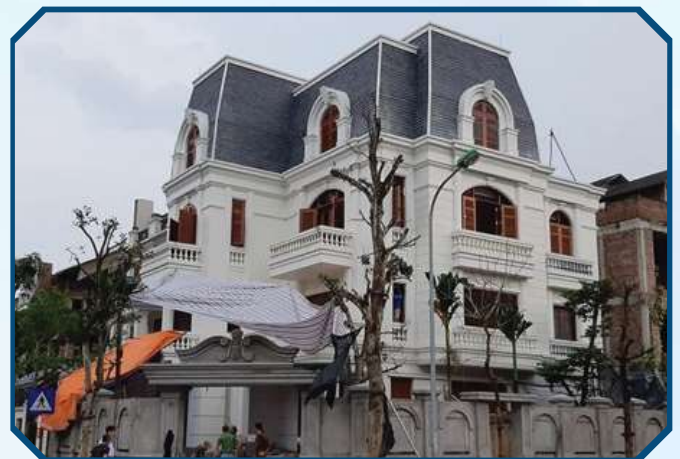
Công trình Biệt Thự 戸建て工事
