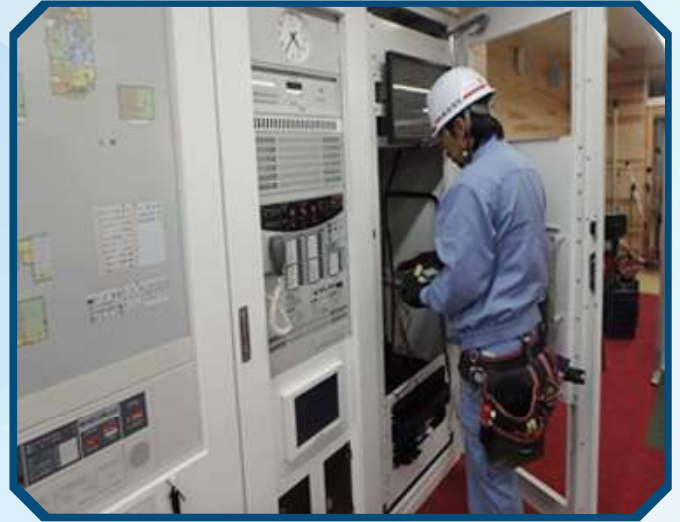
Đo điện áp cấp vào của hệ thống cảnh báo 警報盤絶縁測定
