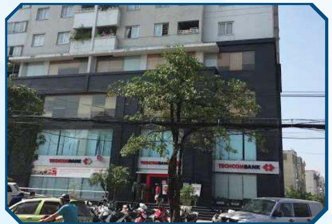
Công trình Chung Cư マンション 工事
