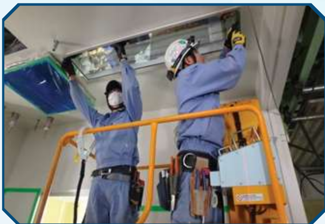
Lắp đặt thiết bị chiếu sáng 照明器具取付状況
