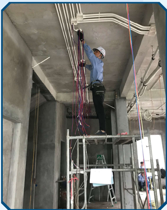
Đi đường dây điện 配線状況
