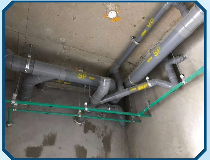
THI CÔNG CẤP THOÁT NƯỚC 建設供給-排水
