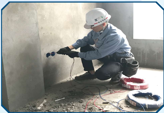
Đi đường dây điện 配線状況
