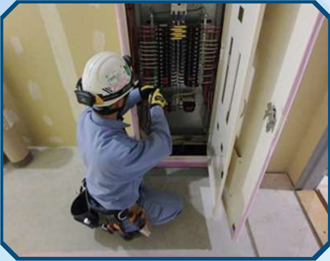
Kết nối tủ điện 配電盤接続状況
