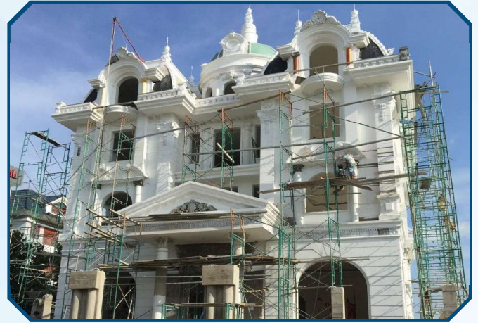
Công trình Biệt Thự 戸建て工事
