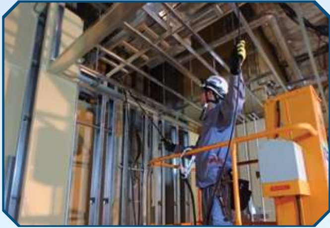
Đi đường dây điện 配線状況
