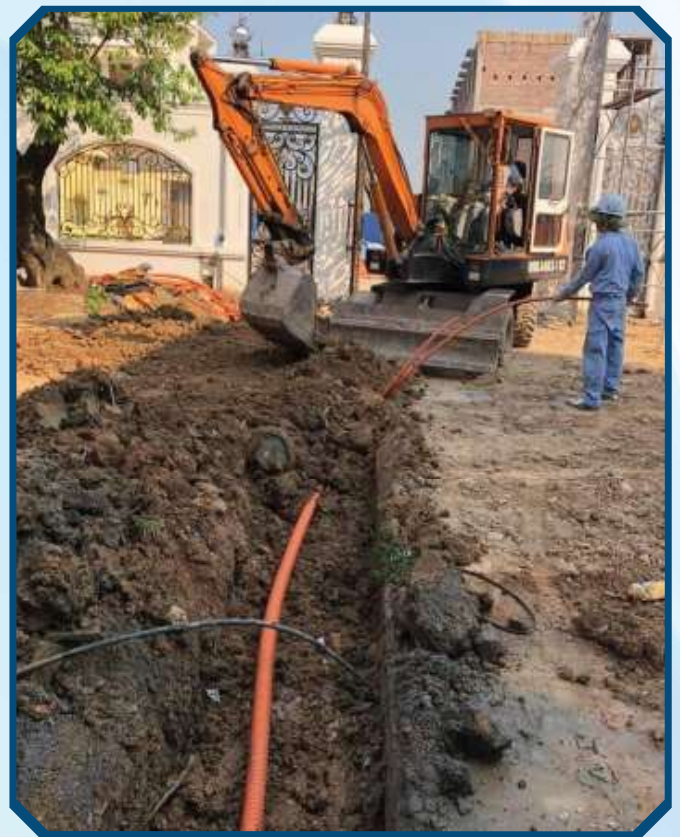
Đi đường dây điện 配線状況
